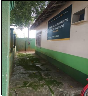
FACHADA DO PAD
