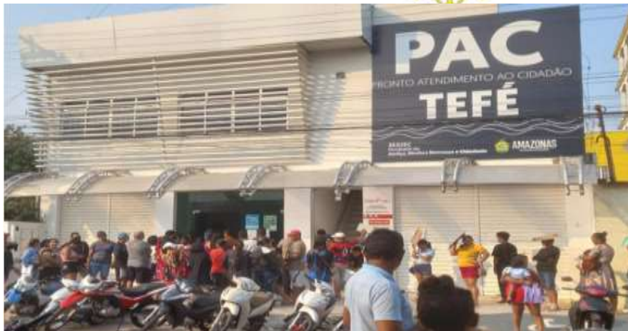
Fachada do POLO
