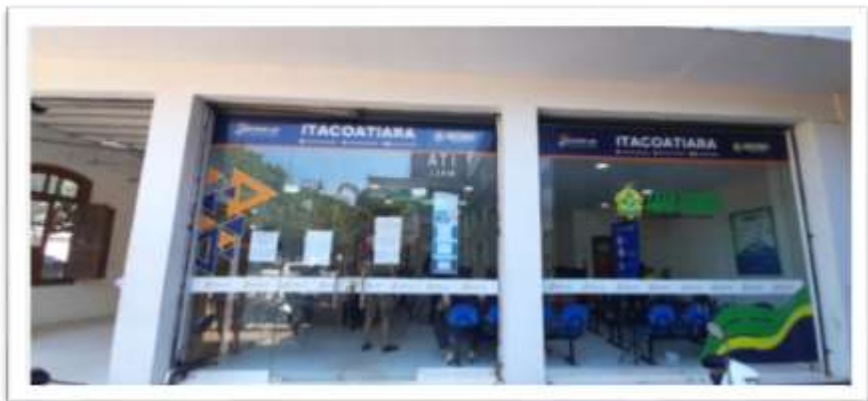
Fachada do PAD
