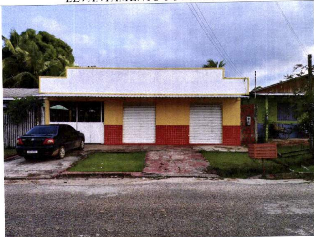
Foto 01 – Levantamento de predio para abrigar o PAD Eirunepé.
